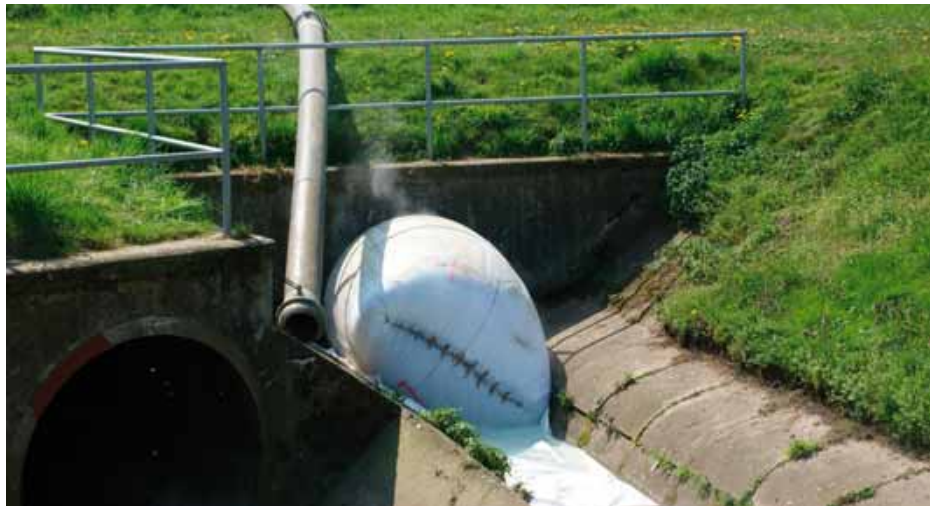
Bild 3: „Kopf“ (Schlauchende) des Liners während der Aushärtung
