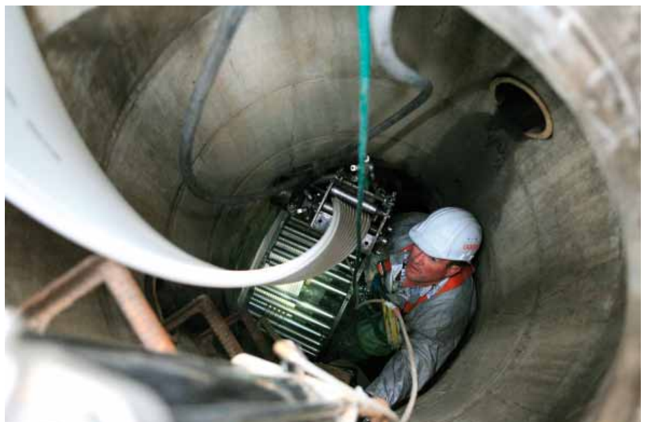
Bild 9: Wickelrohrreinbau in Betonkanal, DN 800
