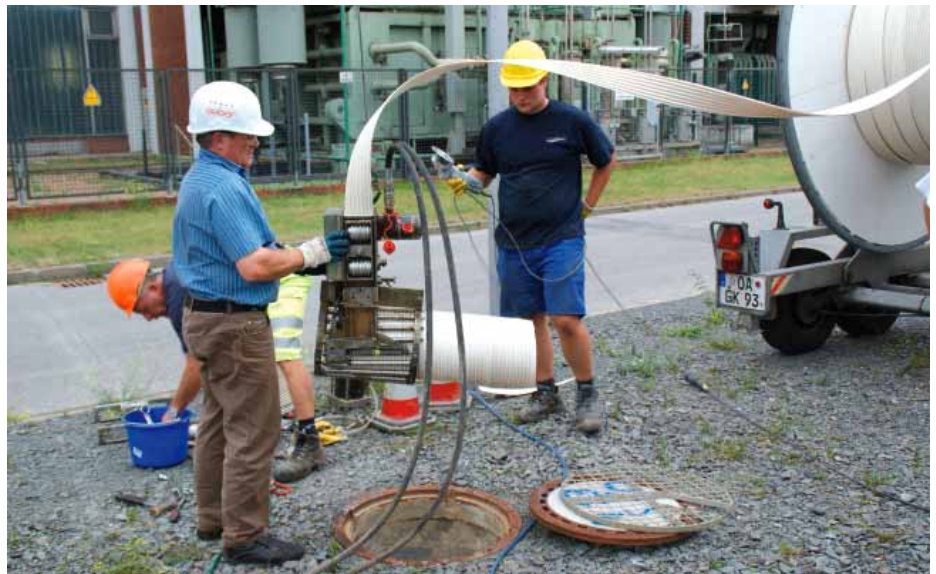
Bild 8: Funktionsprüfung der Wickelmaschine vor Einbau in den Startschacht
