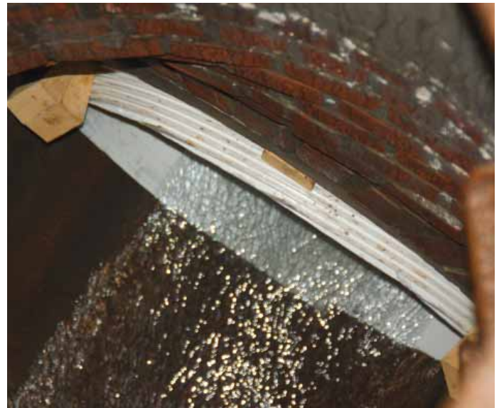
Bild 11: Fixierung des Inliners mittels Holzkeilen
