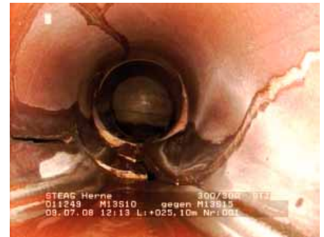
Bild 4: Starke Scherbenbildung im Steinzeugkanal, DN 300
