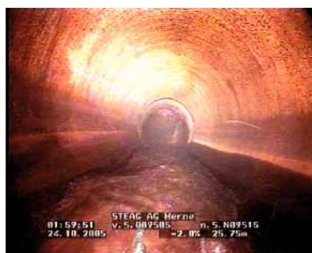
Bild 5: Trockenwetterabfluss im Betonkanal, DN 800
